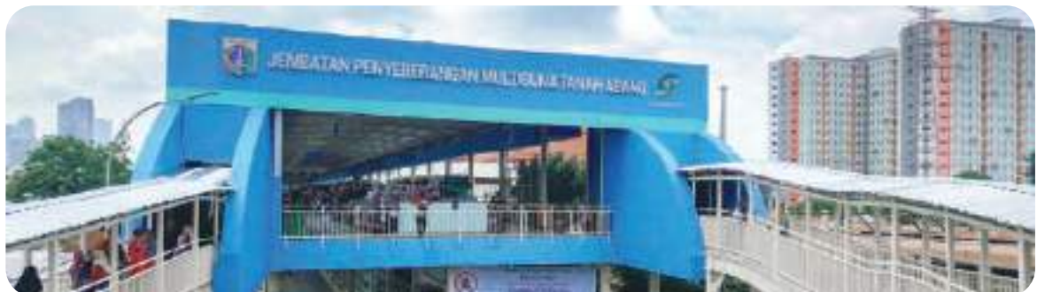
Jembatan Penyeberangan Multifungsi (JPM) Multipurpose Crossing Bridge (JPM)
